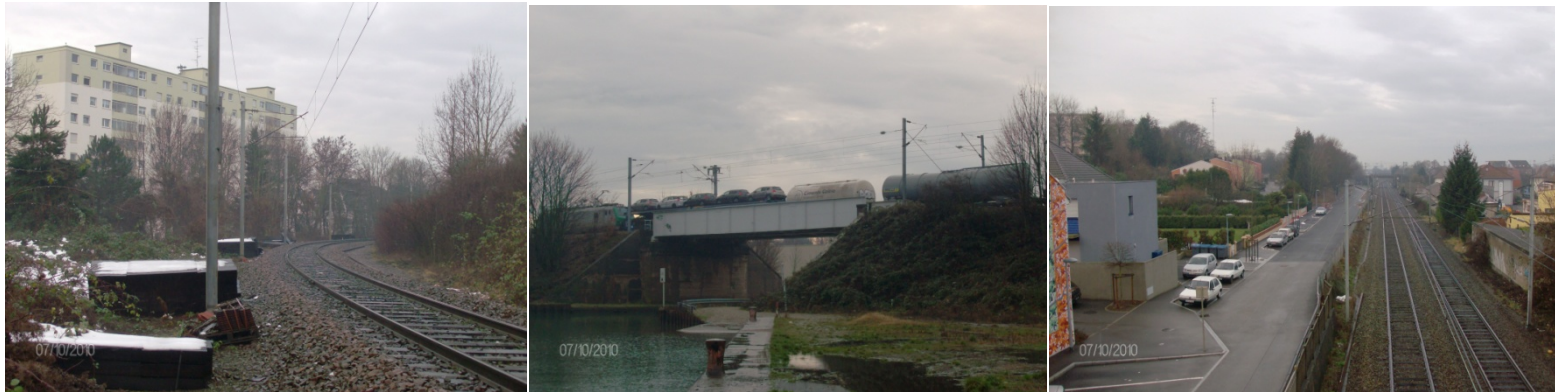
Photos 1 et 2 : voie de contournement
